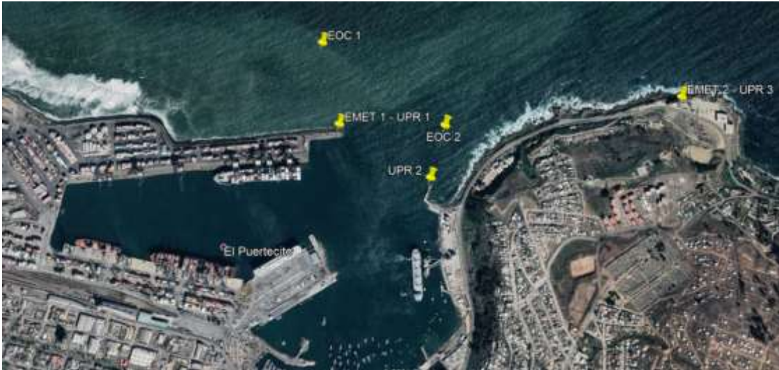
Figura 2. Ubicación Sensores Sistema VCMOV.
